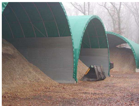
hangar tunnel bâché type serre photo sté Copobois
